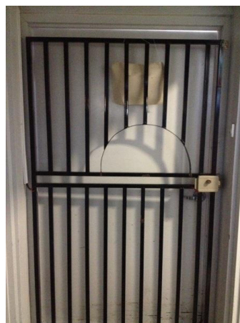
Fotografía 6: Puerta ingreso Bodega Servicios de Proveduría.
