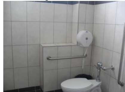
Servicio sanitario modulo 2
