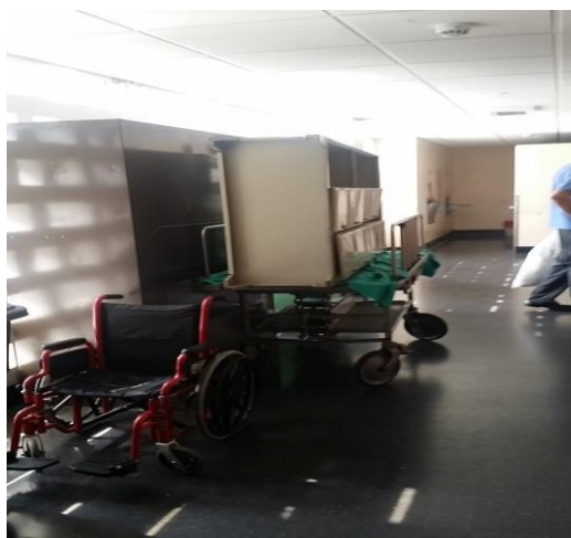
Figura 10: Activos ubicados en la entrada de los ascensores del piso 3
