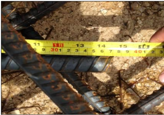
Inspección del 20 al 24 de octubre 2014
