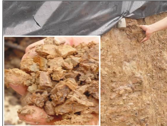
Inspección del 20 al 24 de octubre 2014
