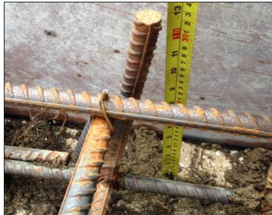
Inspección del 20 al 24 de octubre 2014
