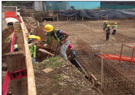
Inspección del 20 al 24 de octubre 2014
