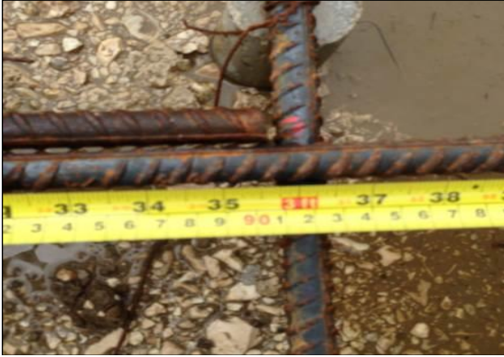
Inspección del 20 al 24 de octubre 2014
