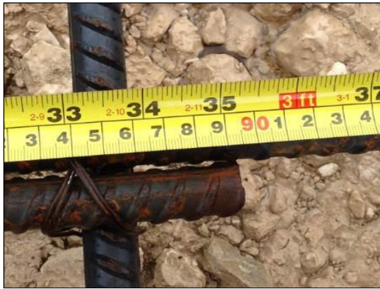
Inspección del 20 al 24 de octubre 2014
