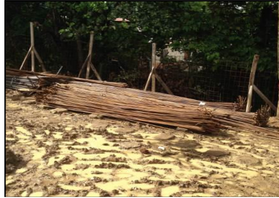
Inspección del 20 al 24 de octubre 2014
