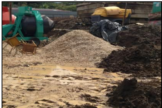
Inspección del 20 al 24 de octubre 2014
