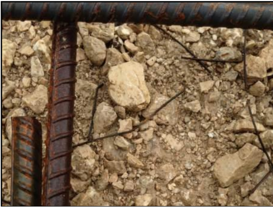
Inspección del 20 al 24 de octubre 2014
