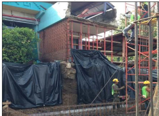
Inspección del 20 al 24 de octubre 2014
