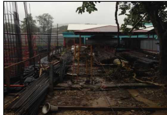
Inspección del 20 al 24 de octubre 2014
