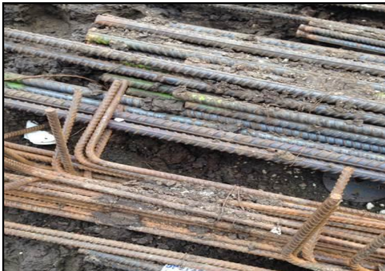
Inspección del 20 al 24 de octubre 2014
