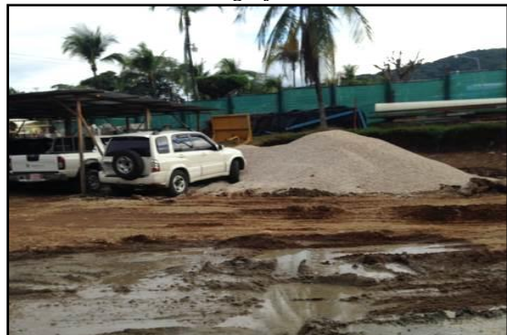
Inspección del 20 al 24 de octubre 2014
