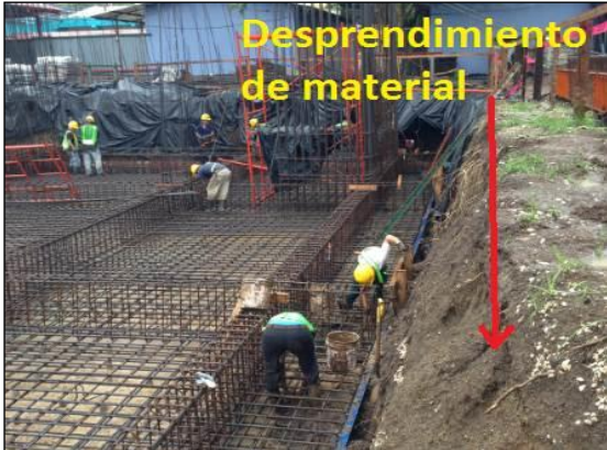
Inspección del 20 al 24 de octubre 2014
