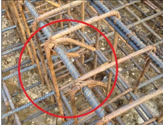
Inspección del 20 al 24 de octubre 2014
