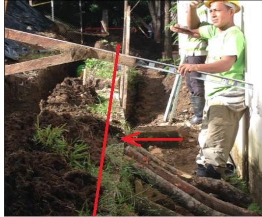
Inspección del 20 al 24 de octubre 2014
