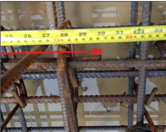
Inspección del 20 al 24 de octubre 2014
