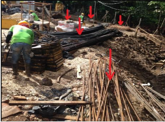
Inspección del 20 al 24 de octubre 2014
