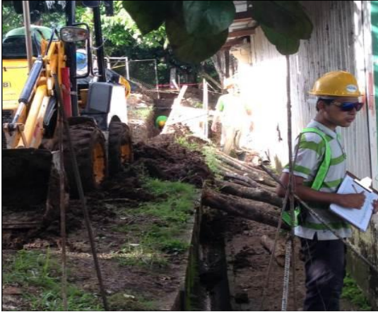
Inspección del 20 al 24 de octubre 2014
