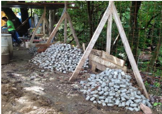
Inspección del 20 al 24 de octubre 2014
