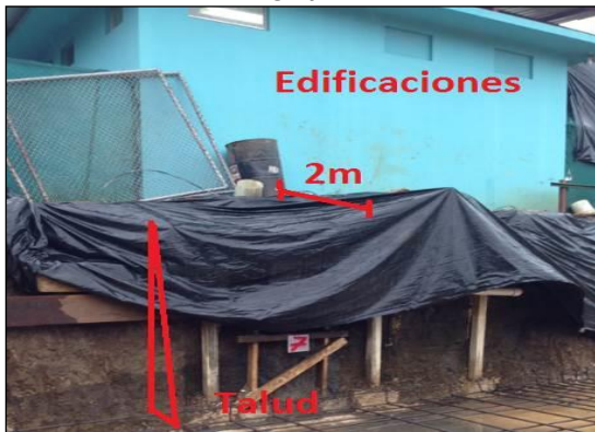
Inspección del 20 al 24 de octubre 2014
