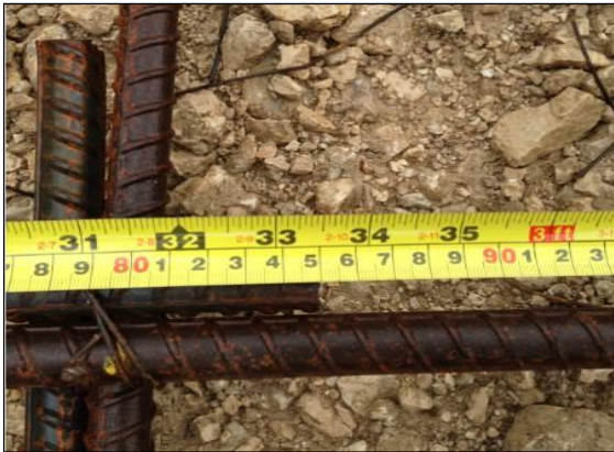
Inspección del 20 al 24 de octubre 2014
