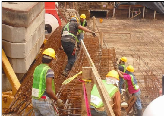
Inspección del 20 al 24 de octubre 2014
