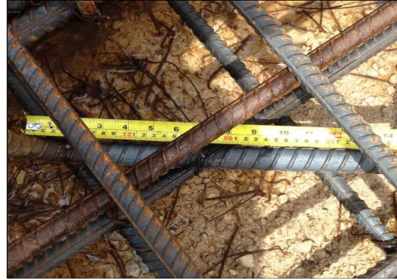
Inspección del 20 al 24 de octubre 2014
