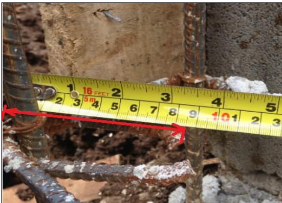
Inspección del 20 al 24 de octubre 2014
