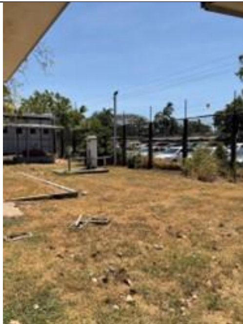
Fotografía 16: Malla perimetral y luces exteriores colindantes con calle pública del Módulo 3.
