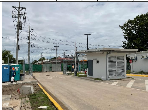
Fotografía 11: Caseta de seguridad vehicular con cámara de seguridad, luminaria exterior y agujas automatizadas, ubicada en el costado oeste (entrada secundaria).
