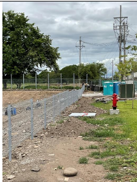
Fotografía 14: Malla perimetral interna de 1.20 metros de altura bordea laguna de retención.
