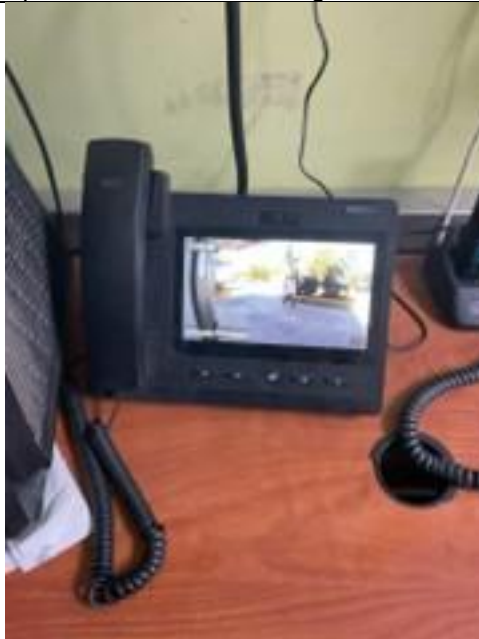
Fotografía 12: Teléfono con cámara conectado al intercomunicador ubicado en la entrada de Sala de Choque del Servicio de Emergencias en el Módulo 1.
