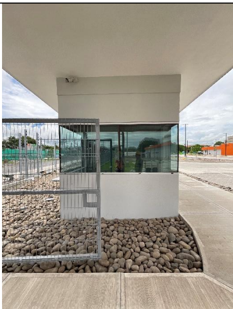
Fotografía 9: Caseta de seguridad para control peatonal y cámara de seguridad, ubicada en el costado norte (entrada principal peatonal).
