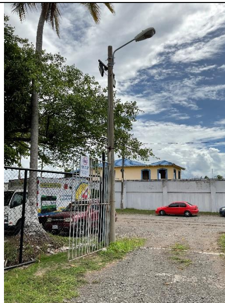
Fotografía 8: Luminarias externas del Módulo 1 sector sur colindante con la playa y oeste colindante con calle pública.
