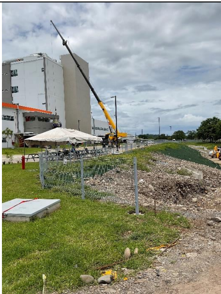
Fotografía 13: Malla perimetral interna de 1.20 metros de altura bordea laguna de retención.
