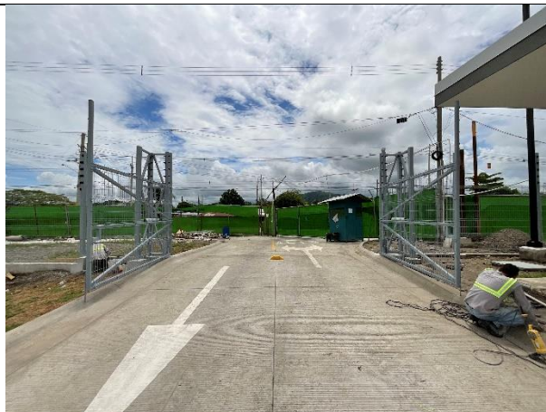
Fotografía 2: Portón vehicular con cerca electrificada con 5 hilos y motor eléctrico de pistones ubicada en el costado norte (entrada principal).
