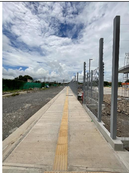
Fotografía 8: Anden peatonal externo malla perimetral con cerca electrificada de 5 hilos ubicado en el costado norte.
