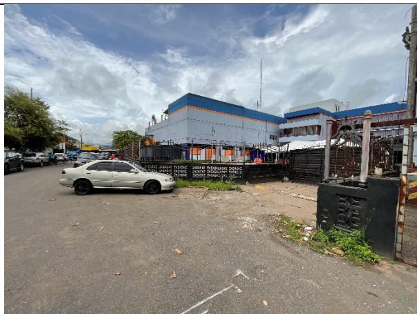
Fotografía 6: Malla perimetral de muro y portón del Módulo 1 sector oeste colindante con calle pública.
