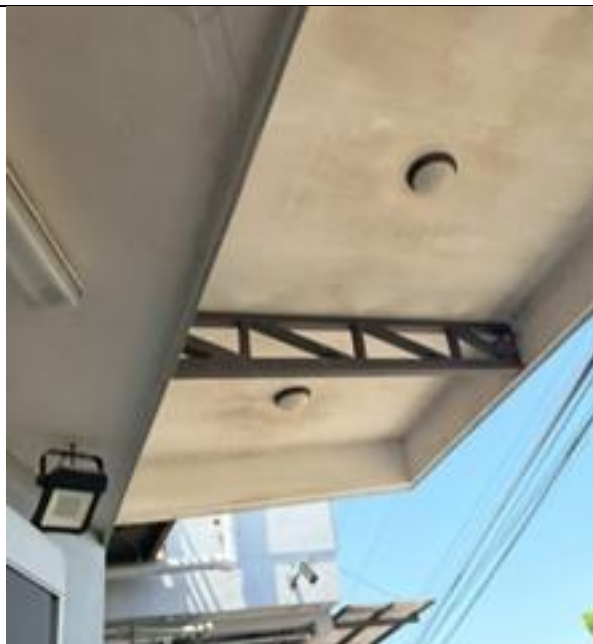
Fotografía 10: Luces exteriores en la entrada de Sala de Choque del Servicio de Emergencias en Módulo 1.
