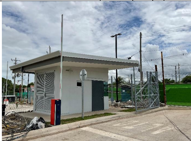
Fotografía 3: Caseta de seguridad vehicular con cámara de seguridad, luminaria exterior, agujas automatizadas y malla perimetral con cerca electrificada de 5 hilos, ubicada en el costado norte (entrada principal).
