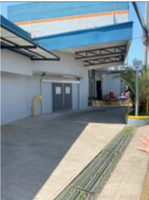
Fotografía 9: Entrada de Sala de Choque del Servicio de Emergencias en el Módulo 1.
