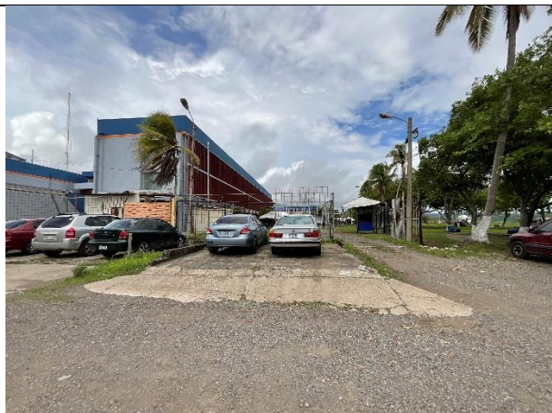
Fotografía 5: Entrada vehicular con malla perimetral en malas condiciones del Módulo 1 sector oeste colindante con calle pública.
