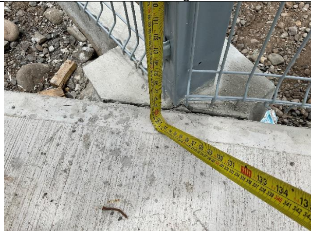
Fotografía 16: Detalle de verificación de altura de malla perimetral y cerca electricada con 5 hilos correspondiente a 3 metros aproximadamente.
