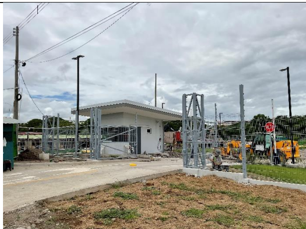
Fotografía 1: Caseta de seguridad vehicular con cámara de seguridad, luminaria exterior y malla perimetral con cerca electrificada de 5 hilos, ubicada en el costado norte (entrada principal).
