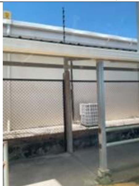
Fotografía 20: Malla perimetral colindante con propiedad privada en sector este del Módulo 3.
