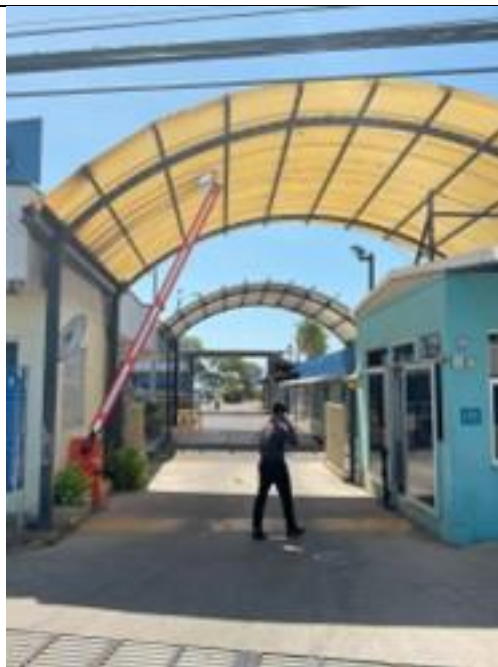
Fotografía 14: Entrada vehicular al Módulo 1 del centro médico.
