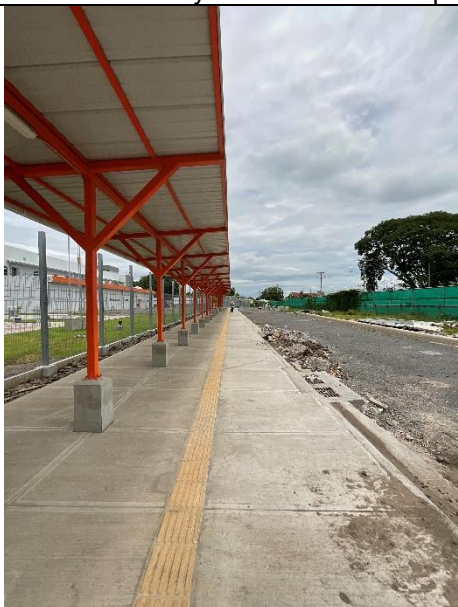
Fotografía 7: Anden peatonal externo con cubiertas y malla perimetral con cerca electrificada de 5 hilos ubicado en el costado norte.
