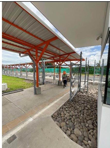
Fotografía 10: Porton de acceso peatonal abatible, cerca electrificada de 5 hilos fija y cubiertas contiguo a la caseta de seguridad
