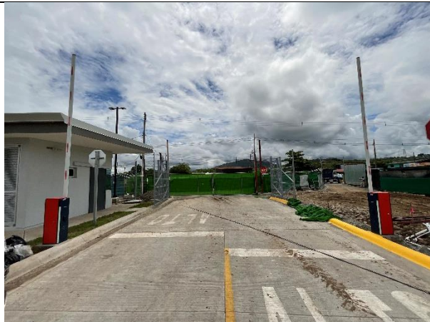
Fotografía 4: Caseta de seguridad vehicular, porton vehicular con cerca electrificada de 5 hilos y agujas automatizadas ubicada en el costado norte (entrada principal).
