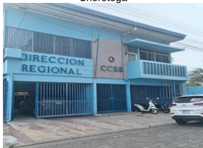
Imagen 16 Edificio Dirección Regional de Sucursales Chorotega
