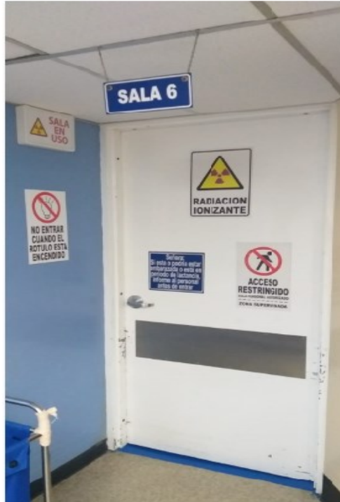
Imagen 3 Puerta entrada sala No. 6 Hemodinamia
