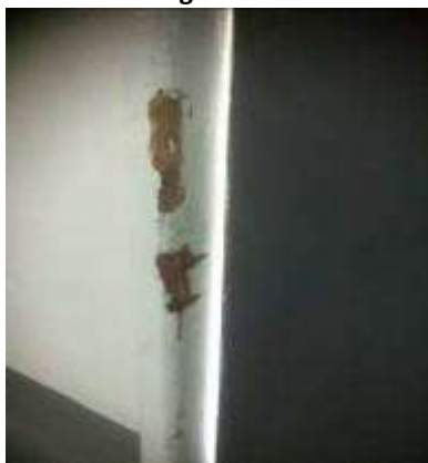
Marcos de madera con desprendimientos y con esparadrapo
