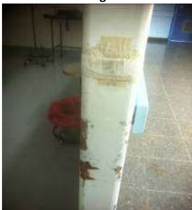
Marcos de madera con desprendimientos y con esparadrapo
