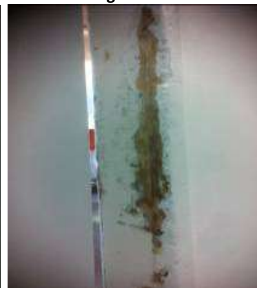
Marcos de madera con desprendimientos y con esparadrapo
