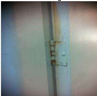
Oxido en bisagras de puertas, cableado expuesto en Sala 02.
