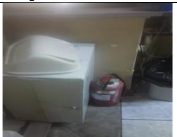
Extintor a nivel de piso
