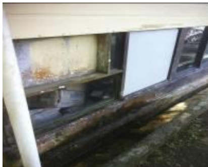
DETERIORO POR HUMEDAD, PRESENCIA DE VEGETACIÓN EN PAREDES.
