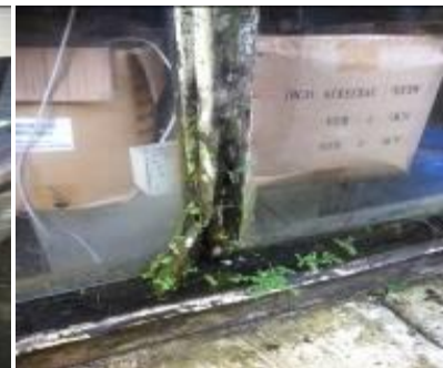
DETERIORO POR HUMEDAD, PRESENCIA DE VEGETACIÓN EN PAREDES.
