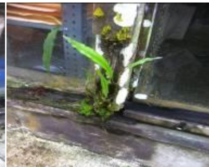
DETERIORO POR HUMEDAD, PRESENCIA DE VEGETACIÓN EN PAREDES.
