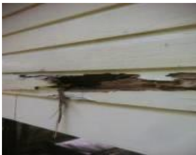
ORIFICIOS EN PAREDES PRODUCTO DEL COMEJEN Y DEL DETERIORO DE LA MADERA.
