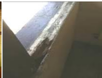
ORIFICIOS EN PAREDES PRODUCTO DEL COMEJEN Y DEL DETERIORO DE LA MADERA.
