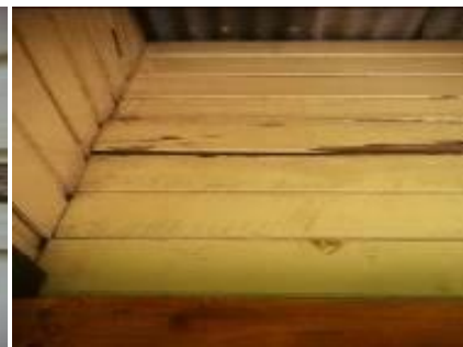
ORIFICIOS EN PAREDES PRODUCTO DEL COMEJEN Y DEL DETERIORO DE LA MADERA.
