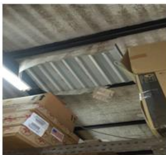
Fotografía N° 9 Aislante de calor desprendido
