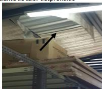
Fotografía N° 9 Aislante de calor desprendido
