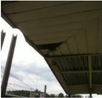
Ausencia de piezas de madera en aleros, precintas dañadas u falta de piezas
