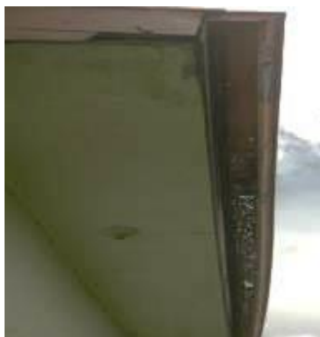
Falta de bombillo, canoas dañadas y desprendimiento de bajante
