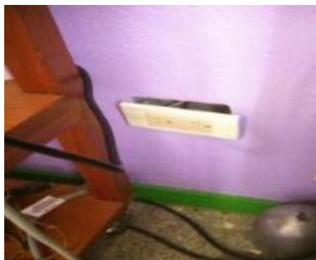
Enchufe desprendido y otro mal instalado
