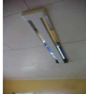
Uniones de canoa dañado, faltante de pieza en precinta y lámpara sin fluorescente
