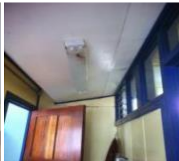
Desprendimiento de cielo raso, falta de bombillos y lámparas fluorescentes
