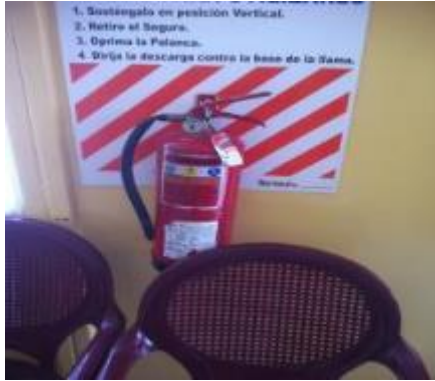
Extintor descargado
