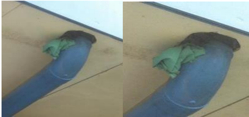
BAJANTE DE CANOA SUJETO CON TROZO DE TELA.
