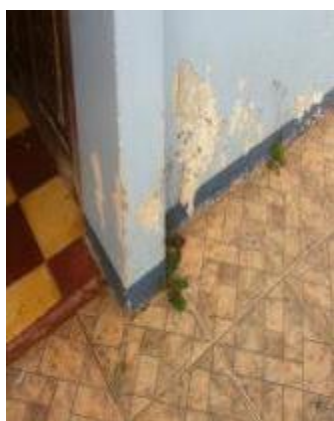
Paredes con daños en la pintura y vegetación
