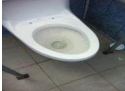
Servicio sanitario sin manilla para la descarga de agua e inodoro con fuga de agua
