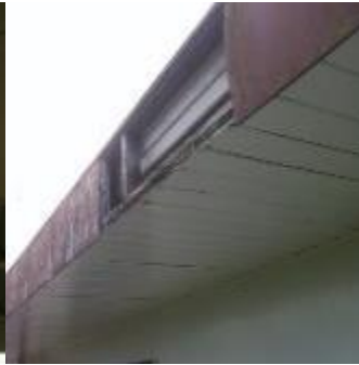
Ausencia de piezas de madera en aleros, precintas dañadas u falta de piezas
