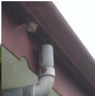
Vegetación en la cubierta de techo y bajante, desprendimiento de pintura
