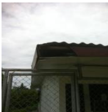
Uniones de canoa dañado, faltante de pieza en precinta y lámpara sin fluorescente
