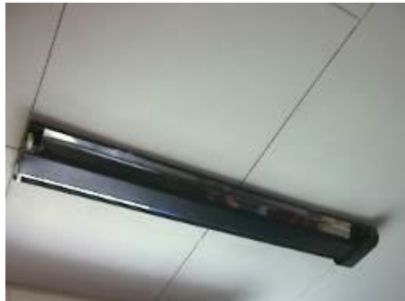
Sala de espera sin electricidad, luminaria sin fluorescente
