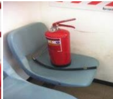
Extintores sin carga y en mal estado
