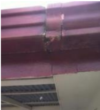
Uniones de canoa dañado, faltante de pieza en precinta y lámpara sin fluorescente
