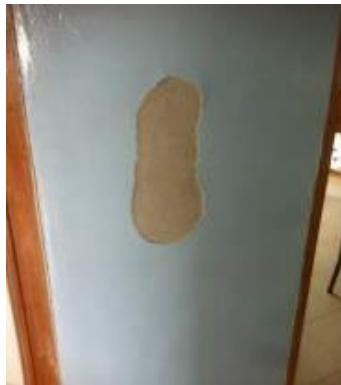
Paredes con daños en pintura, desprendimiento de repello
