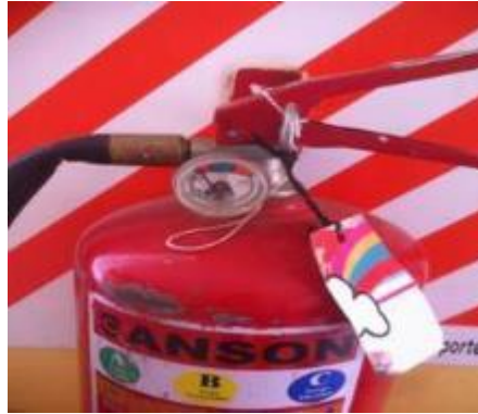
Extintor descargado
