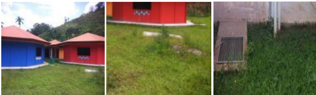
Zonas verdes sin el mantenimiento adecuado
