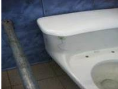
Servicio sanitario sin manilla para la descarga de agua e inodoro con fuga de agua
