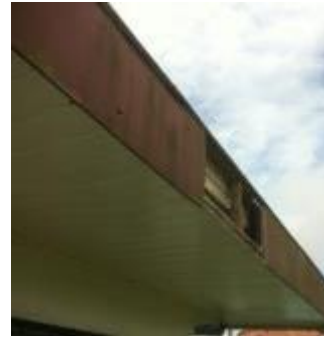
Ausencia de piezas de madera en aleros, precintas dañadas u falta de piezas
