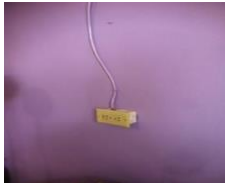
Enchufe desprendido y otro mal instalado
