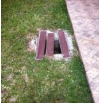
Tapas de registro dañadas, paredes deterioradas
