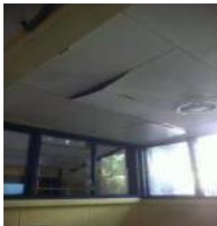
Desprendimiento de cielo raso, falta de bombillos y lámparas fluorescentes
