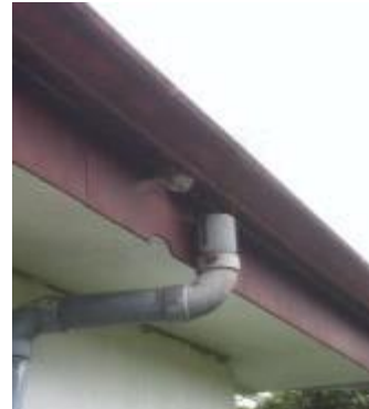
Falta de bombillo, canoas dañadas y desprendimiento de bajante
