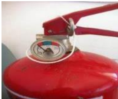
Extintores sin carga y en mal estado
