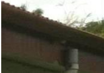
Vegetación en la cubierta de techo y bajante, desprendimiento de pintura
