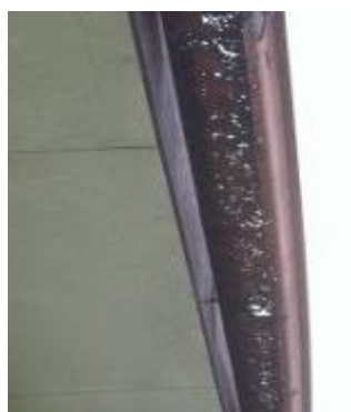
Falta de bombillo, canoas dañadas y desprendimiento de bajante
