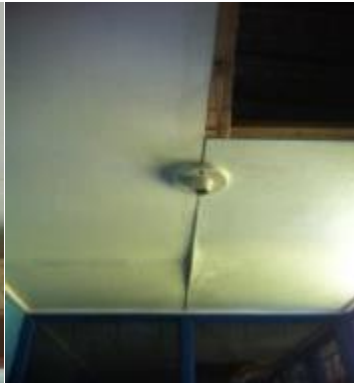
Daños por filtraciones y ausencia de piezas en cielos rasos
