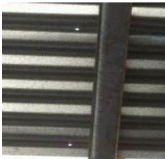
Perforaciones en láminas de cubierta de techo, desprendimiento de pintura y ausencia de rodapié
