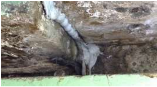
Reparaciones para disminuir problemas de goteo de agua
