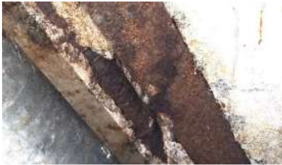
Tuberías en mal estado
