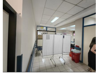
Pasillo donde se realizará una pared de división
