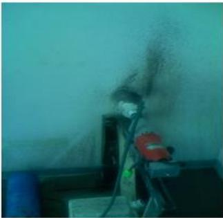
Extracción de núcleos de concreto para probarlos en laboratorio
